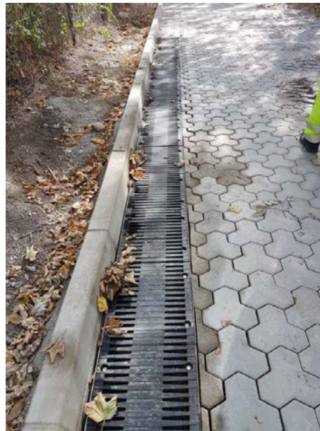
Einbau der Behandlungsanlage BIRCOpur® längs zur Fahrbahn in mehreren Strängen, Ausführung in Betonverbundsteinpflaster mit Gefälle in Richtung Rinne am Randstein
