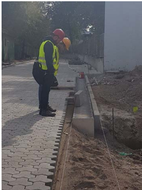
Einbau der Behandlungsanlage BIRCOpur® längs zur Fahrbahn in mehreren Strängen, Ausführung in Betonverbundsteinpflaster mit Gefälle in Richtung Rinne am Randstein
