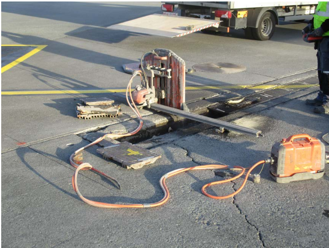
Mit einer Betonsäge wird der Oberflächenbelag rund um das defekte Fremdfabrikat geöffnet
