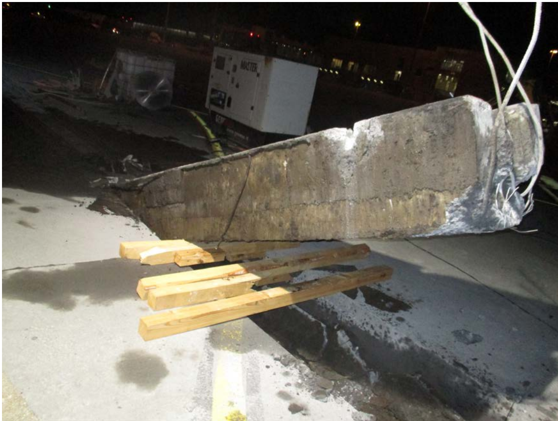
Entfernen des defekten Fremfabrikates
