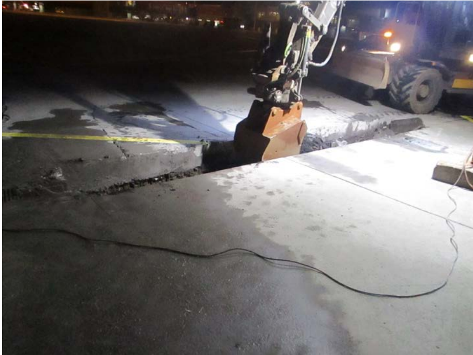
Gezielter Aushub mit minimaler Differenz zur Baubreite der BIRCOport
