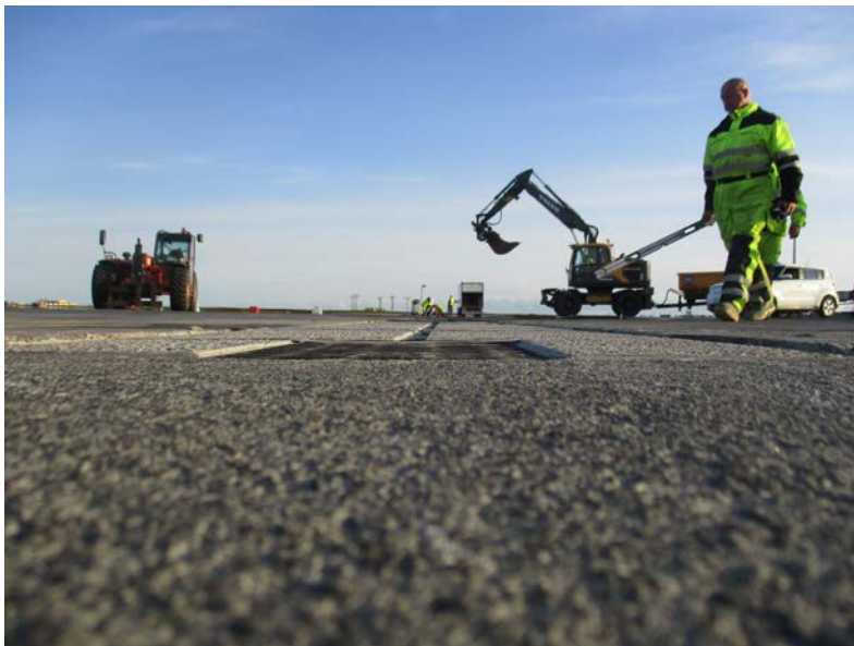
Blick auf das Vorfeld mit Baustelle, Im Vordergrund die vormontierte Revisionsöffnung der BIRCOport.
