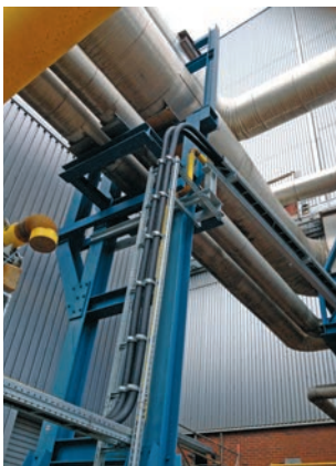
Keine Formteile bei Richtungswechseln erforderlich
