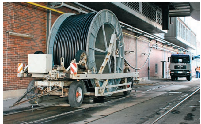
Rohrverlegung von der Trommel direkt auf die Kabelpritschen
