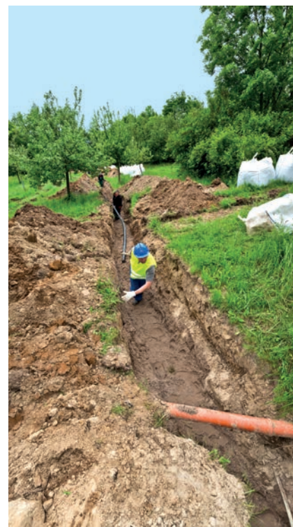
Der geringe Aushub schont das Ökosystem
