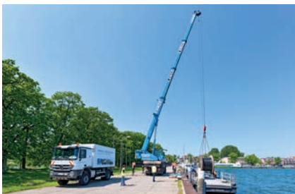
Umsetzen der Rohrtrommel auf die Schute
