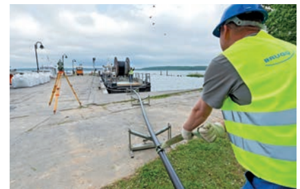
Abtrommeln der Rohrleitung
