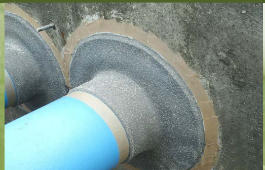
Brandhemmende elastische Zusatzbeschichtungen Fire-retardant elastic additional coating
