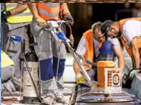
Glätter für die plane Oberfläche
