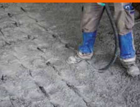
Kontrollierte Verdichtung, engmaschig mit Rüttelflasche ausgeführt.
