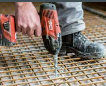
Basis: Engmaschige Armierung auf tragfähigem Untergrund.
