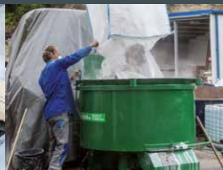
Maschinelle Mischung, mobil auf der Baustelle individuell ausgeführt.
