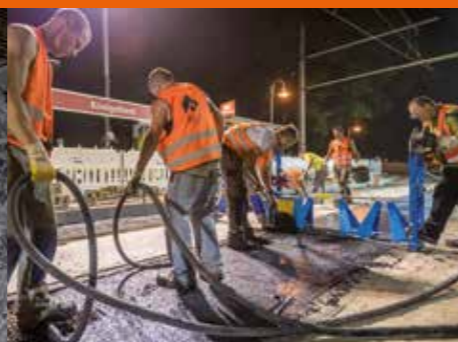
Ebener Einbau mit der Rüttelbohle.
