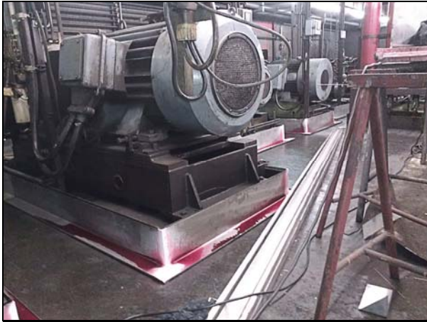
Alte Bodenfläche, schon mit Edelstahlaufkantung versehen
