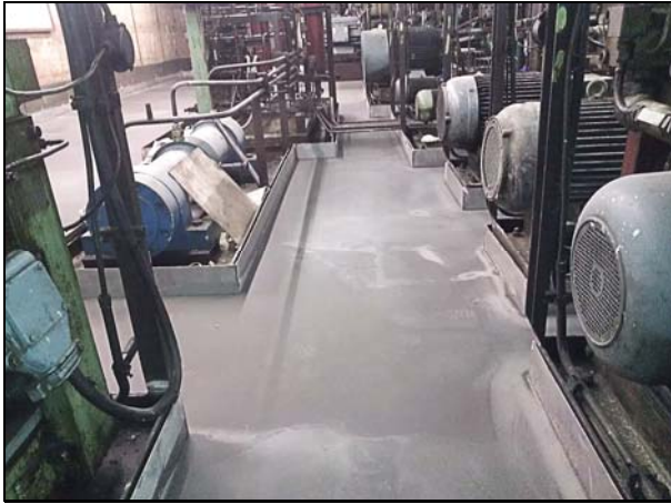
Fertig sanierte Beodenfläche
