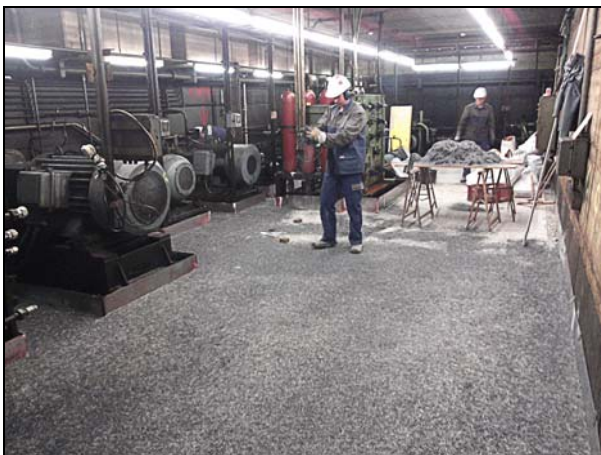
Einstreuen der Stahlfasern
