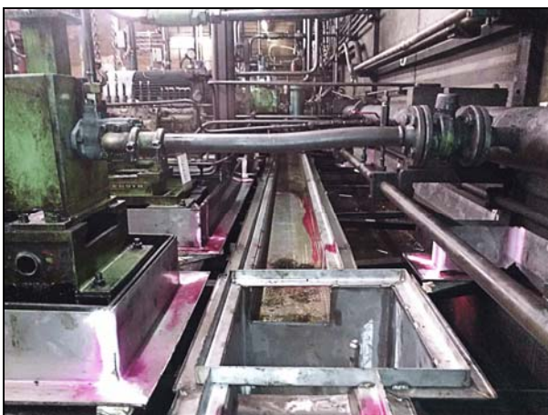
Alte Bodenfläche, schon mit Edelstahlaufkantung versehen
