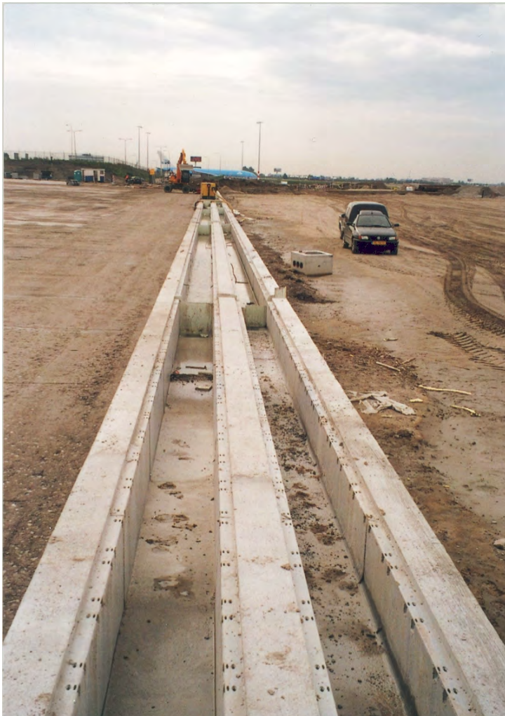
Pier J, Neubau 2006, Rinnensystem BIRCO SIR 500 im Rohbau
